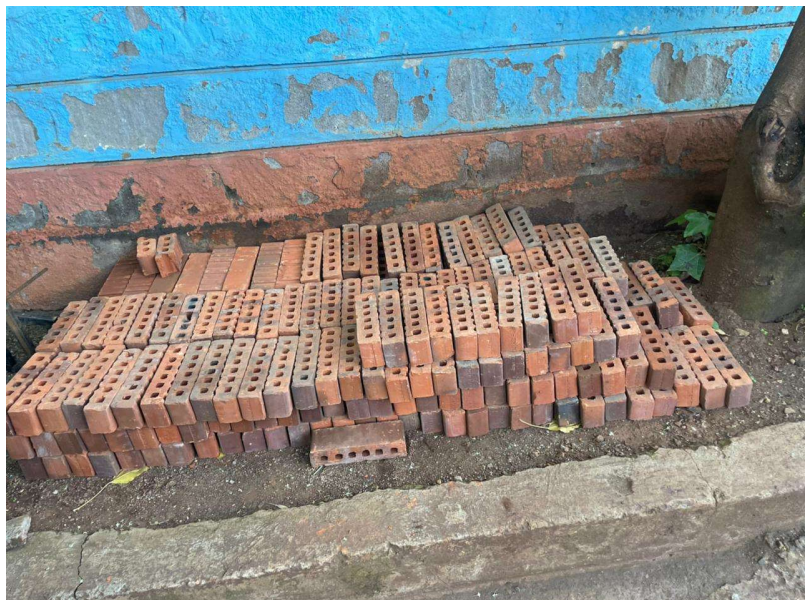
Schamottsteine zur fachkundigen Reparatur
